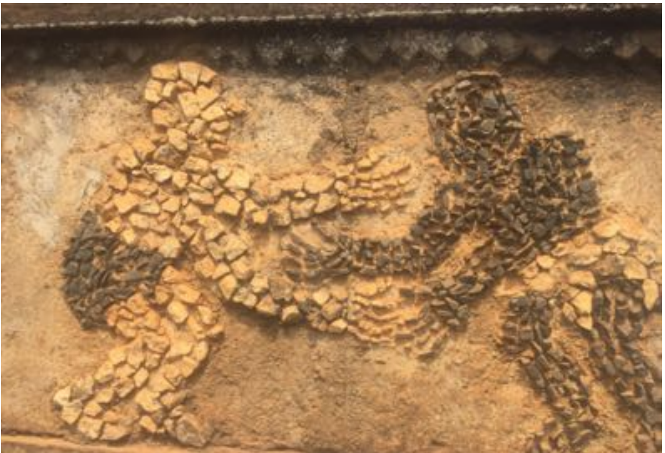
Façade principale de la maison de campagne de Joseph Kengni à Bamendou (Cameroun)
